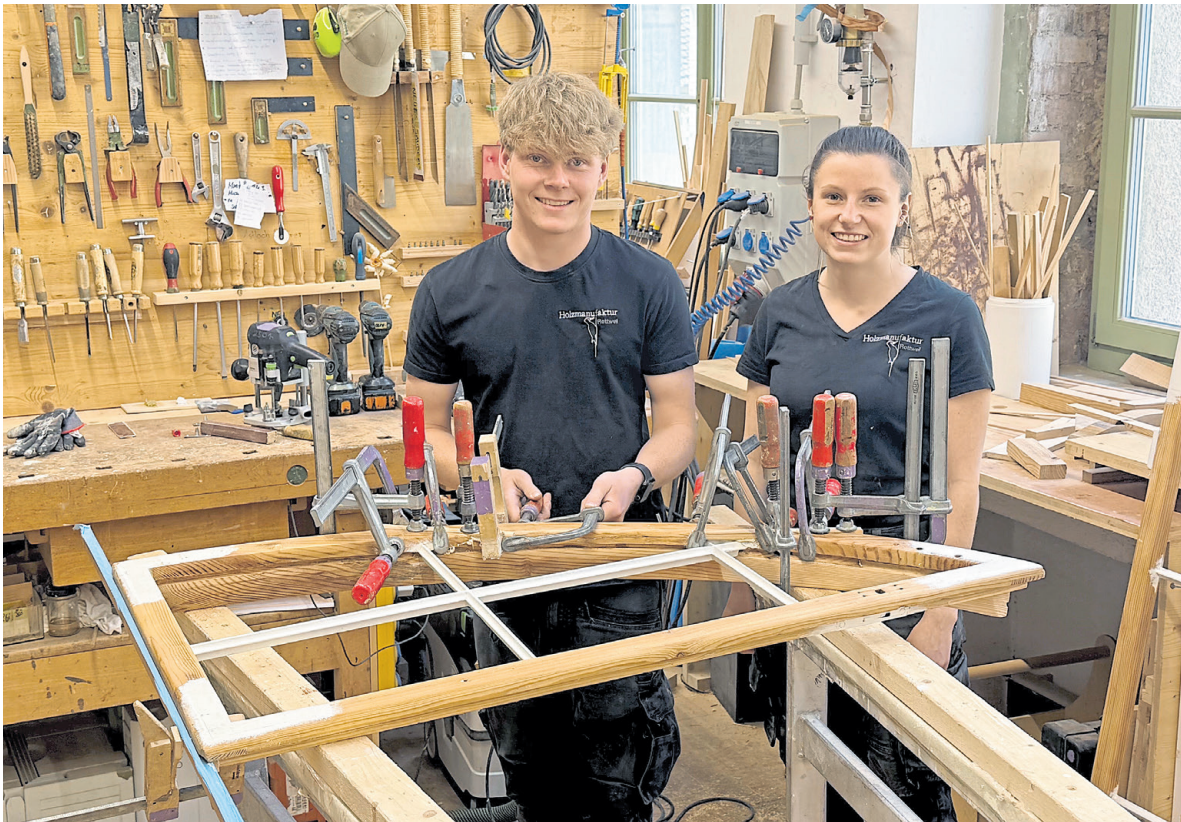
Bei der Holzmanufaktur in Rottweil geht es ums Erhalten: Maximilian Roth und Melanie Ott restaurieren ein altes Fenster. Die Reparatur spart Ressourcen und Energie. Nachhaltige Ziele verfolgt auch die Anti-Abriss-Allianz. Foto: Stefanie Siegmeier
